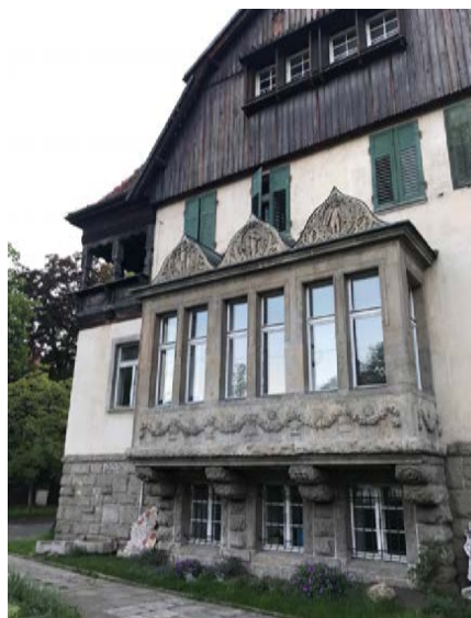
Zdjęcie 2. Fasada domu własnego Paula Ehrlicha od strony ul. Raclawickiej
