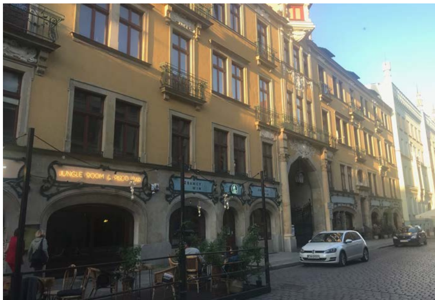
Zdjęcie 4. Fasada kamienicy gminy żydowskiej na ul. Włodkowica
