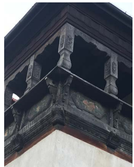
Foto 3: Detail der hölzernen Bauelemente an der Paul-Ehrlich-Villa
